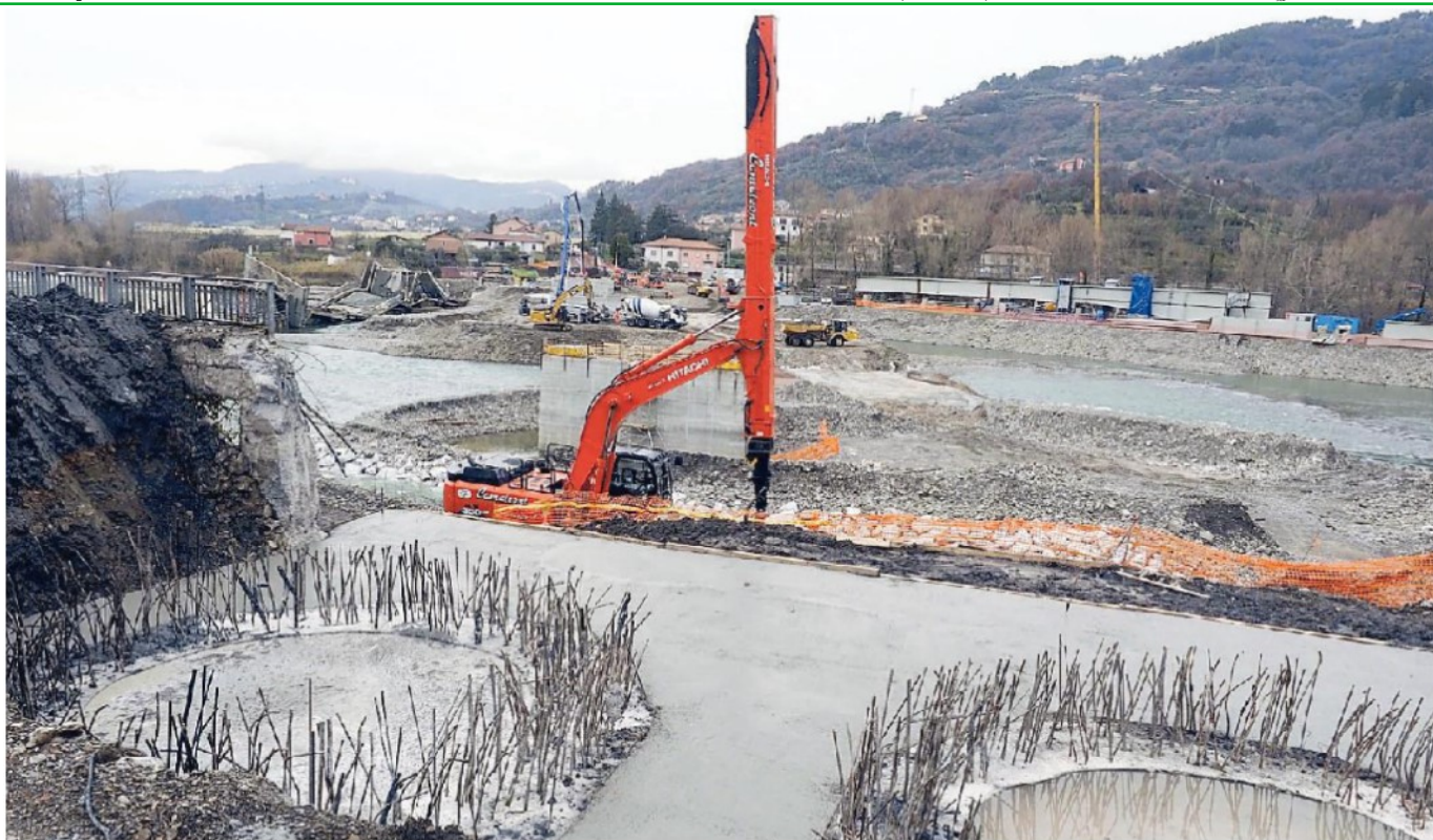
I lavori per il rifacimento del ponte ad Albiano Magra
