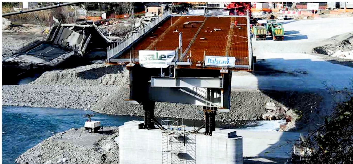
L'impalcato è stato posato sulle pile
